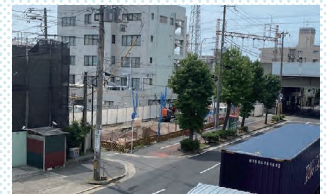
基礎工事開始！
